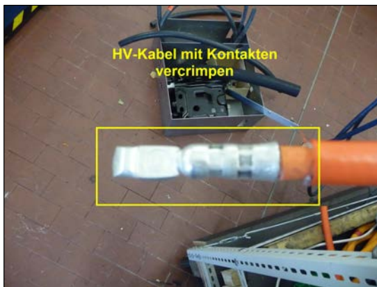
Bild 17: HV-Kabel mit Kontakt vercrimpt
