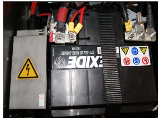
Bild 4: DC/DC Wandler 12V mit Warnhinweis
