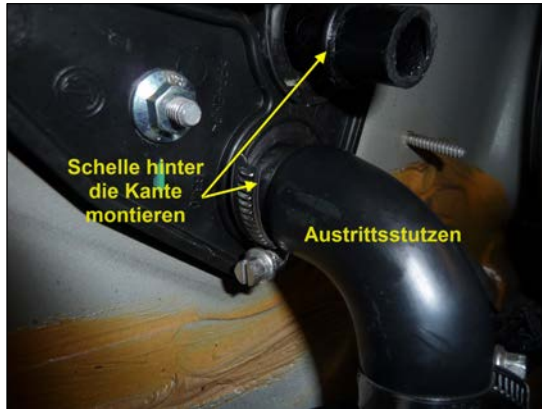
Bild 13: Stutzen des Heizwasserkreislaufs
