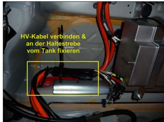
Bild 22: Kabel mit Kabelbinder fixieren
