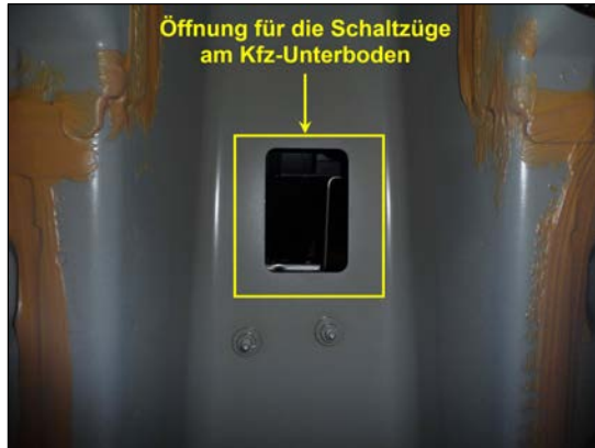
Bild 13: Schalthebelzug-Öffnung im Tunnel
