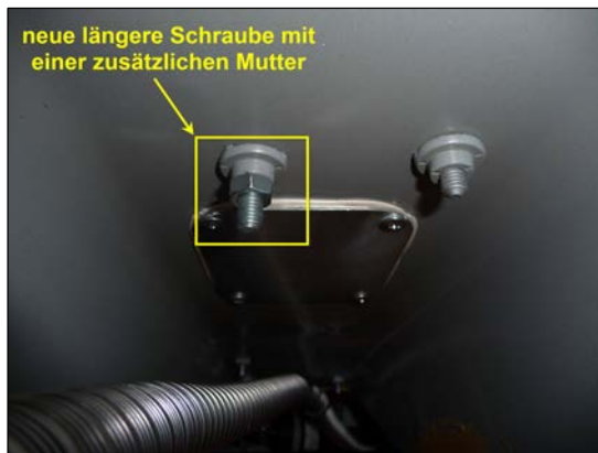
Bild 9: zusätzliche Mutter
