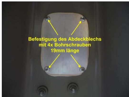
Bild 15: mit 4x Bohrschrauben befestigen
