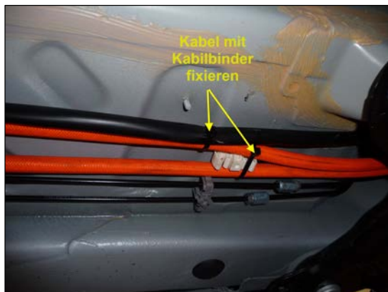
Bild 9: Kabel mit Kabelbindern fixieren
