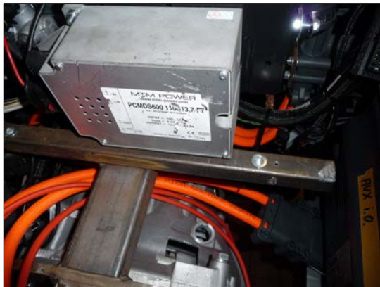
Bild 3: Kabel unter dem Motorträger verlegen
