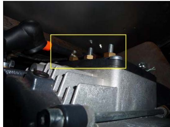
Bild 14: HV-Kabel „W“, „V“ & „U“ anschließen
