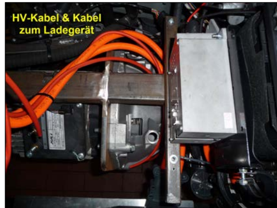
Bild 2: Kabel unter dem Motorträger verlegen
