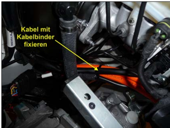
Bild 7: Kabel mit Kabelbinder fixieren
